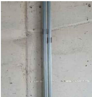
[ 신축 조인트 클립바 시공 ]
