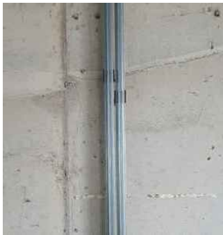
[ 신축 조인트 클립바 시공 ]
